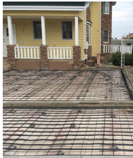
ヒーター敷設工事風景
