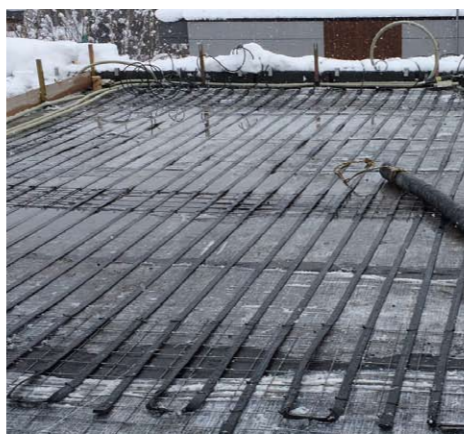
コンクリート埋設前
