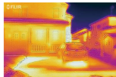
サーモグラフィーで確認
