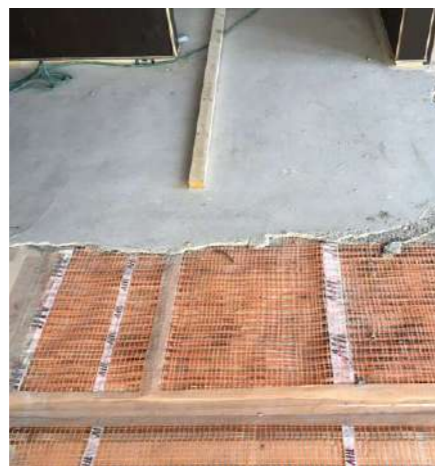
モルタル塗タイル仕上げ
